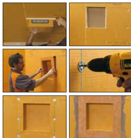
Montáž do KERDI-BOARD
